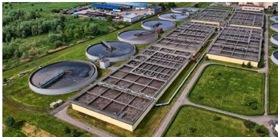
Fot. WMK, Zakład Oczyszczania Ścieków Płaszów w Krakowie
